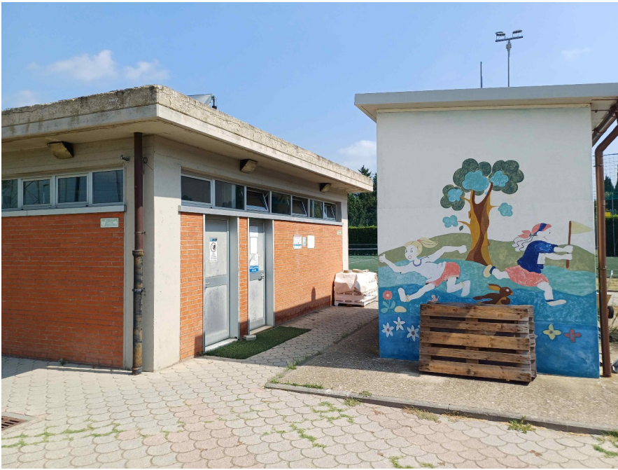
Palazzina spogliatoi e locale centrale termica
