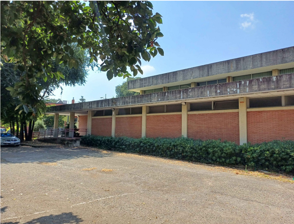
Piazzale esterno lato ingresso carrabile
