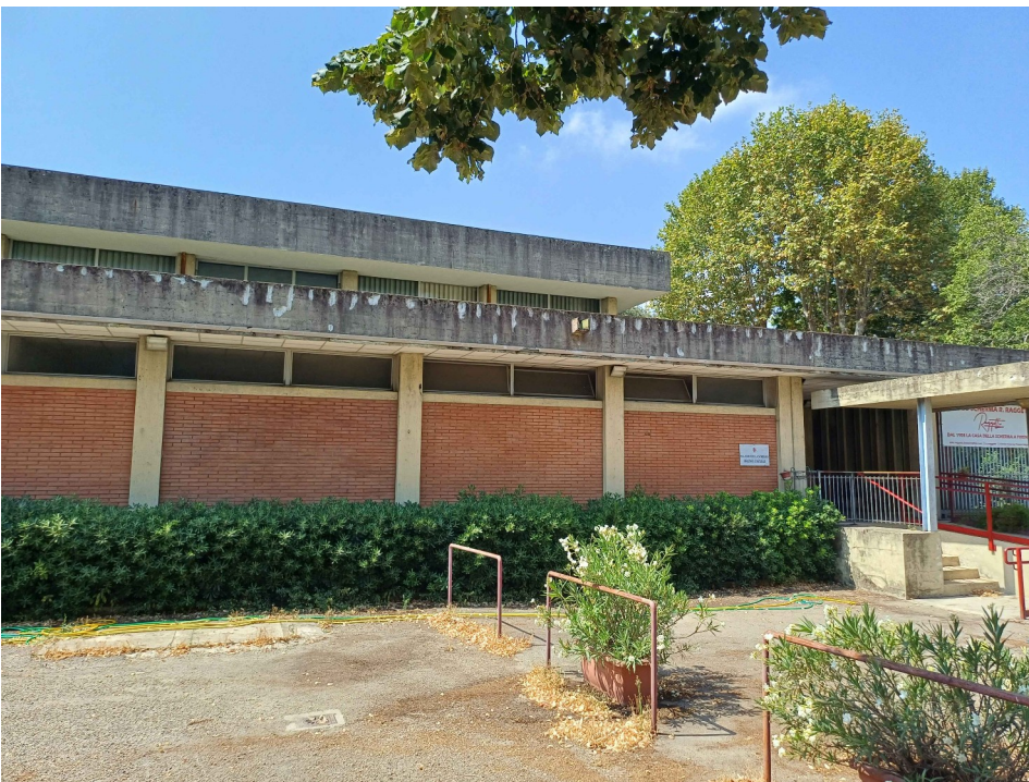
Piazzale esterno lato ingresso pedonale
