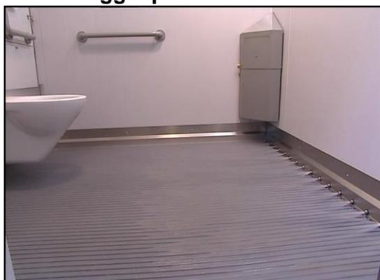
Il lavaggio del pavimento viene effettuato mediante getto d'acqua radente il pavimento
