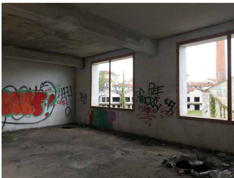
Figura 16: Edificio C, vista interna
