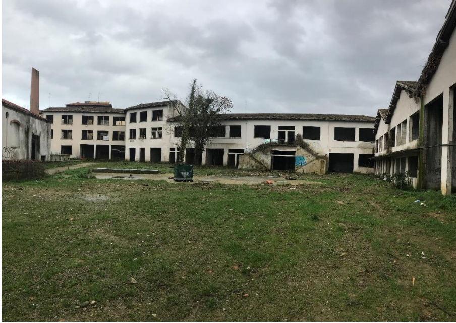
Figura 9: Edificio C, vista esterna dal resede
