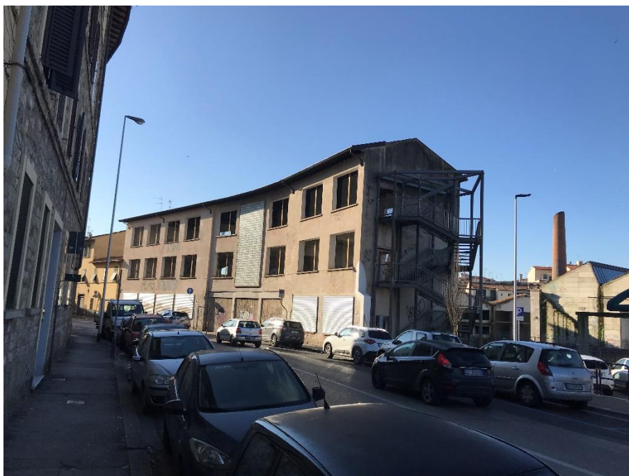
Figura 7: Edificio C, vista esterna da via Alderotti
