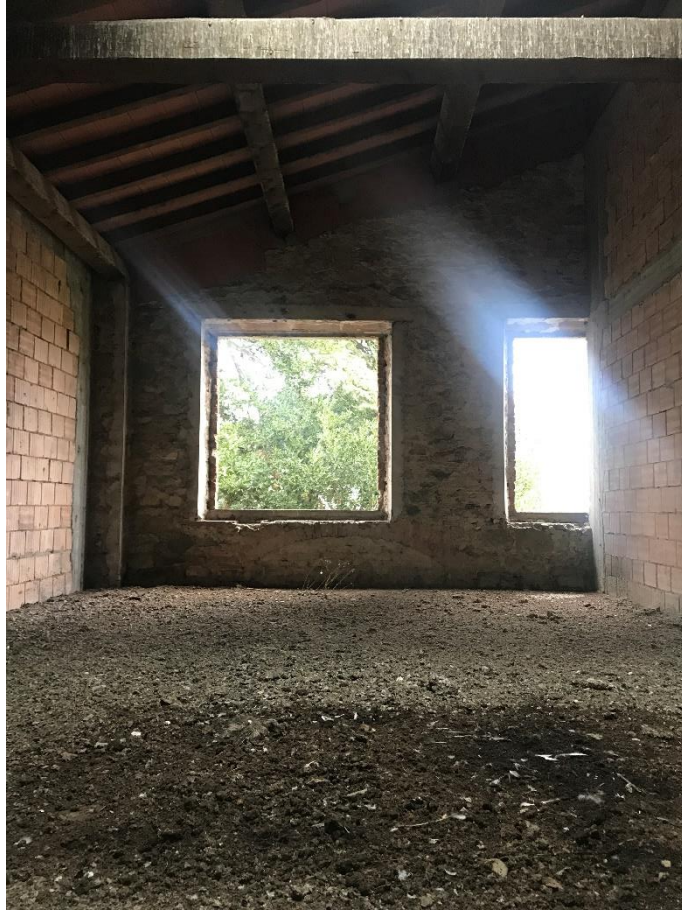
Figura 3: Edificio B, vista interna
