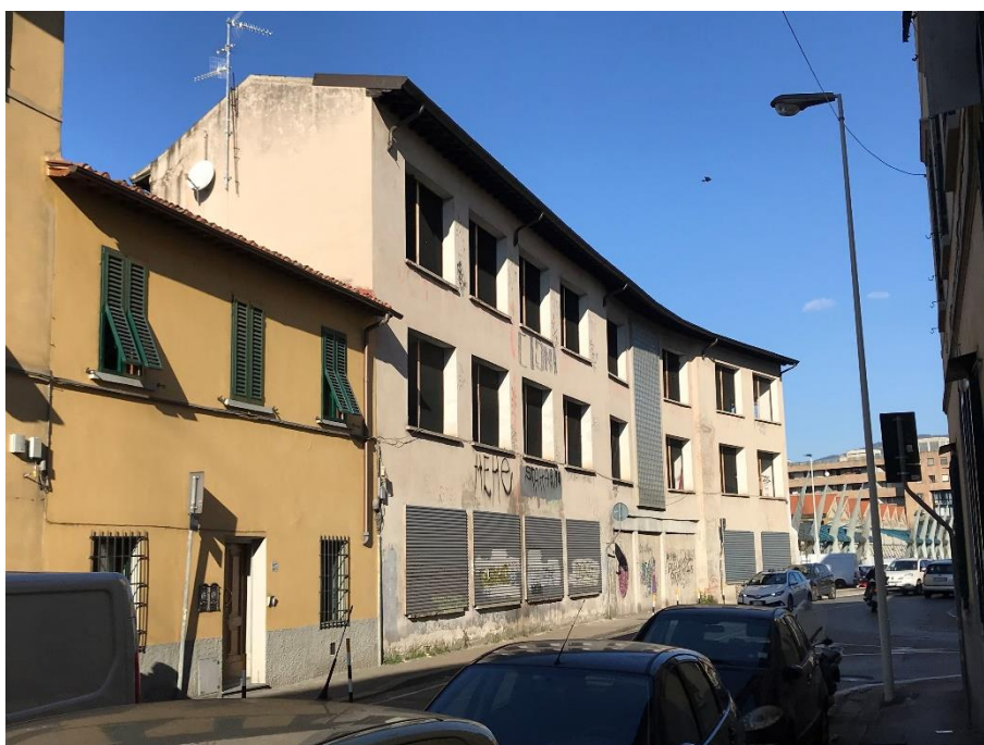
Figura 8: Edificio C, vista esterna da via Alderotti
