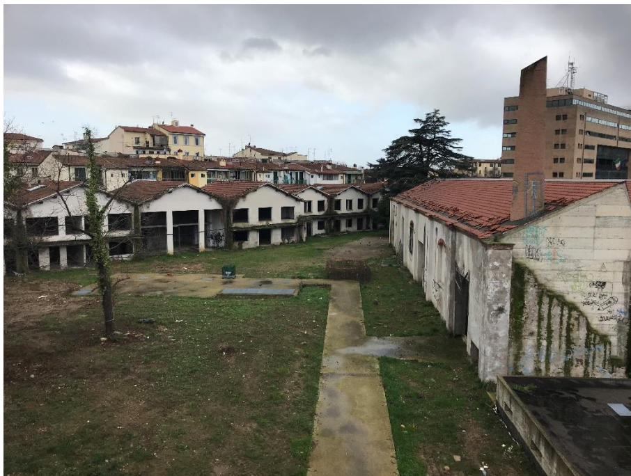
Figura 6: Edificio B (a sinistra), vista esterna dall'edificio C
