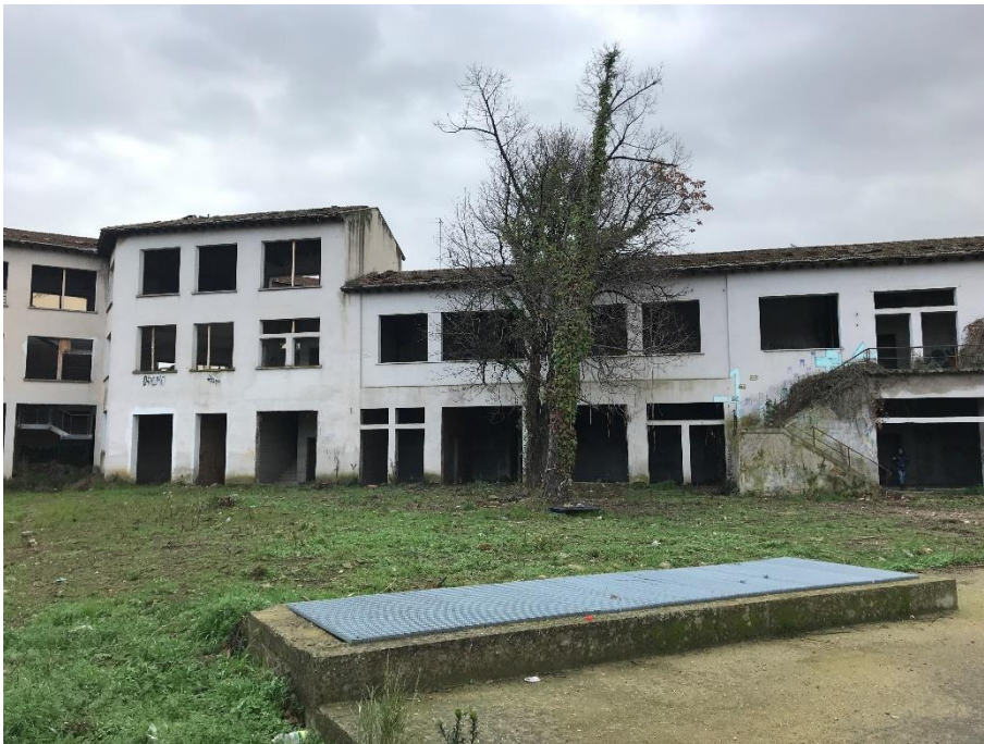
Figura 10: Edificio C, vista esterna dal resede
