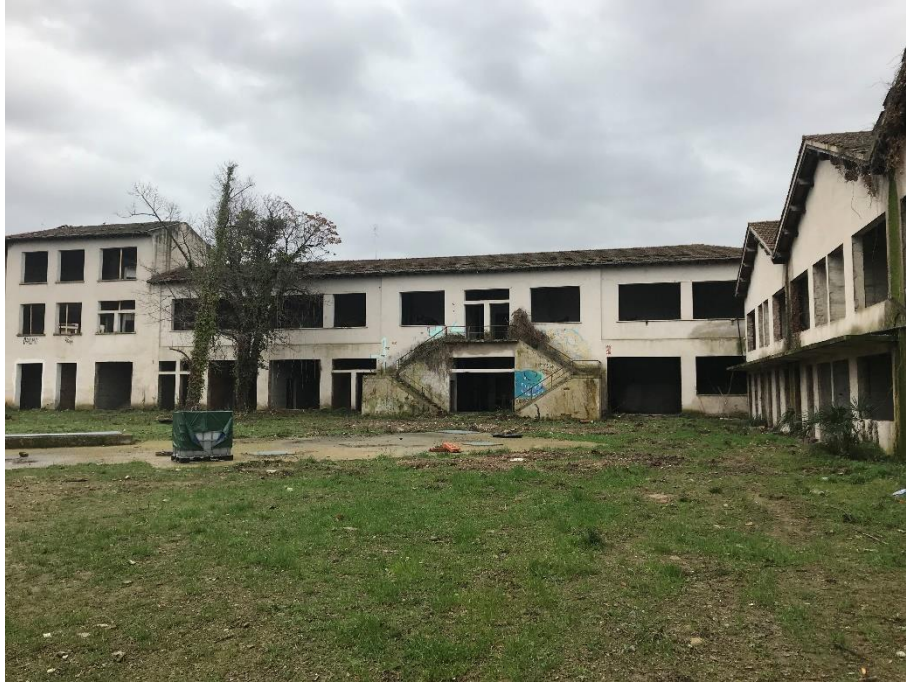
Figura 11: Edificio C, vista esterna dal resede
