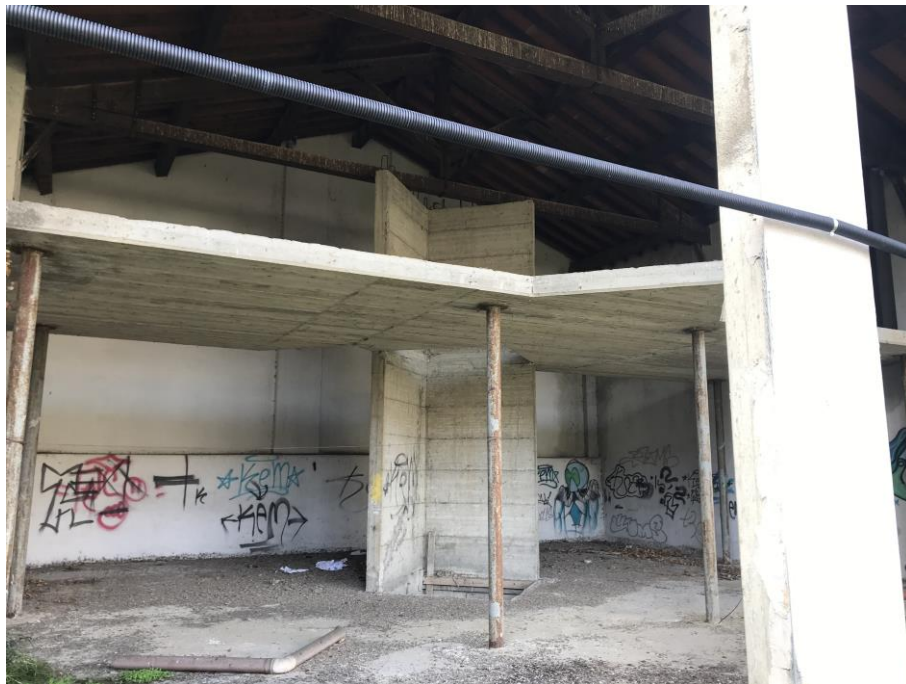
Figura 4: Edificio B, vista interna
