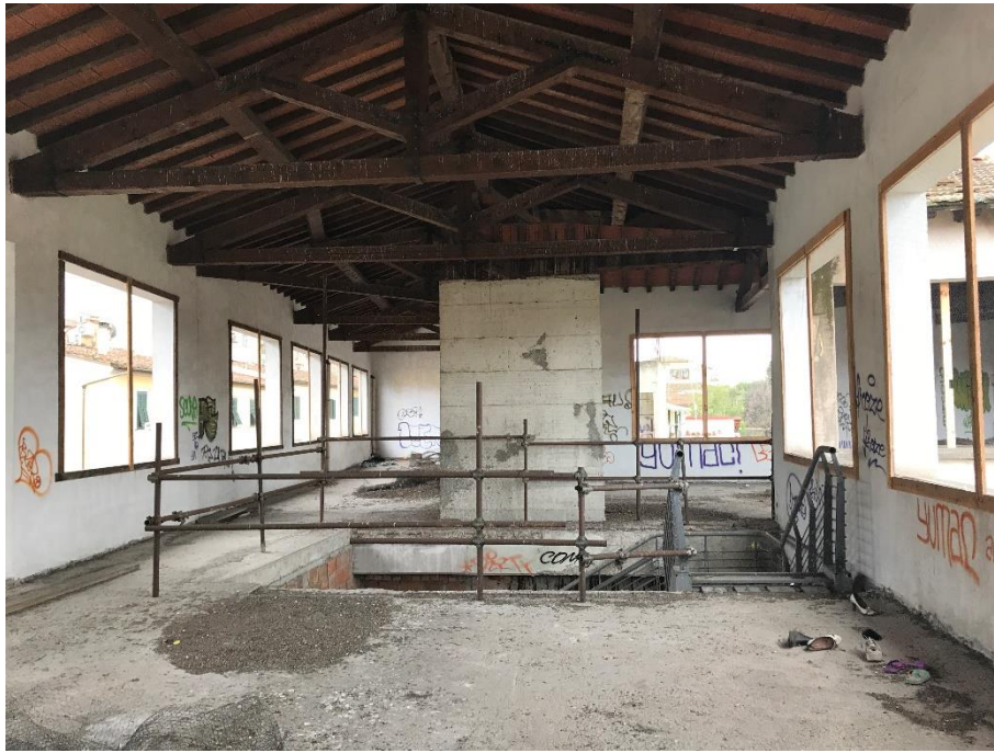
Figura 13: Edificio C, vista interna
