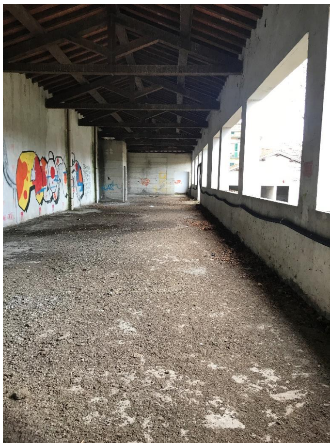
Figura 15: Edificio C, vista interna
