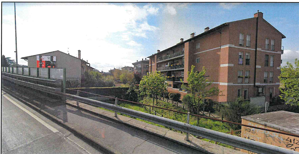
Foto n°1-2 - Nel Cerchio blu evidenziati i ricettori residenziali esposti al traffico di viale Etruria. Con il numero 3 evidenziato il ricettore più critico per la vicinanza alla sede stradale. Come evidenziato nella foto n°2, la barriera esistente protegge parzialmente i ricettori 1 e 2, mentre 3 e 4 di più recente costruzione risultano totalmente scoperti.
