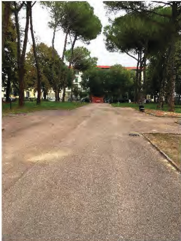
Pavimentazione già realizzata nel lotto 1 di piazza Elia dalla Costa
