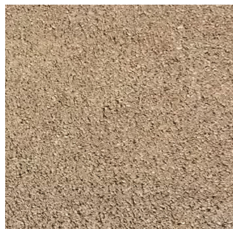
Pavimentazione prevista e già realizzata nella restante parte della piazza
