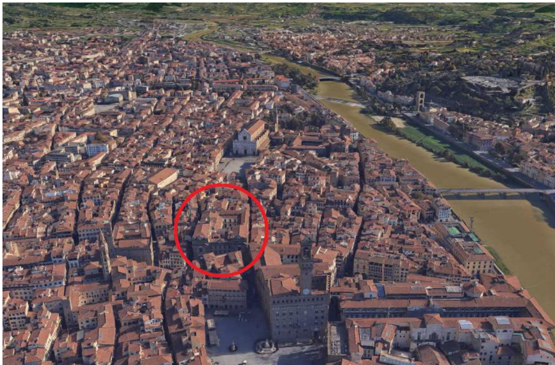
complesso San Firenze -localizzazione nel tessuto cittadino
