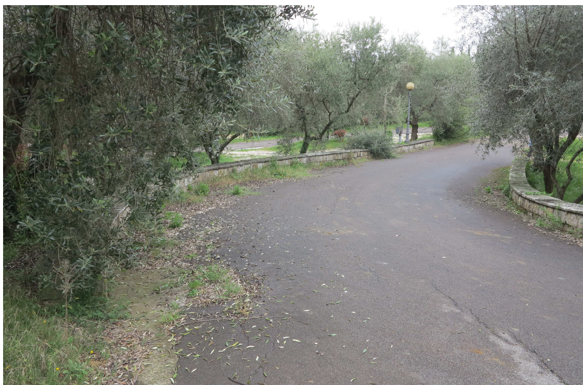
Porzione di percorso asfaltato esistente nell'ex campeggio
