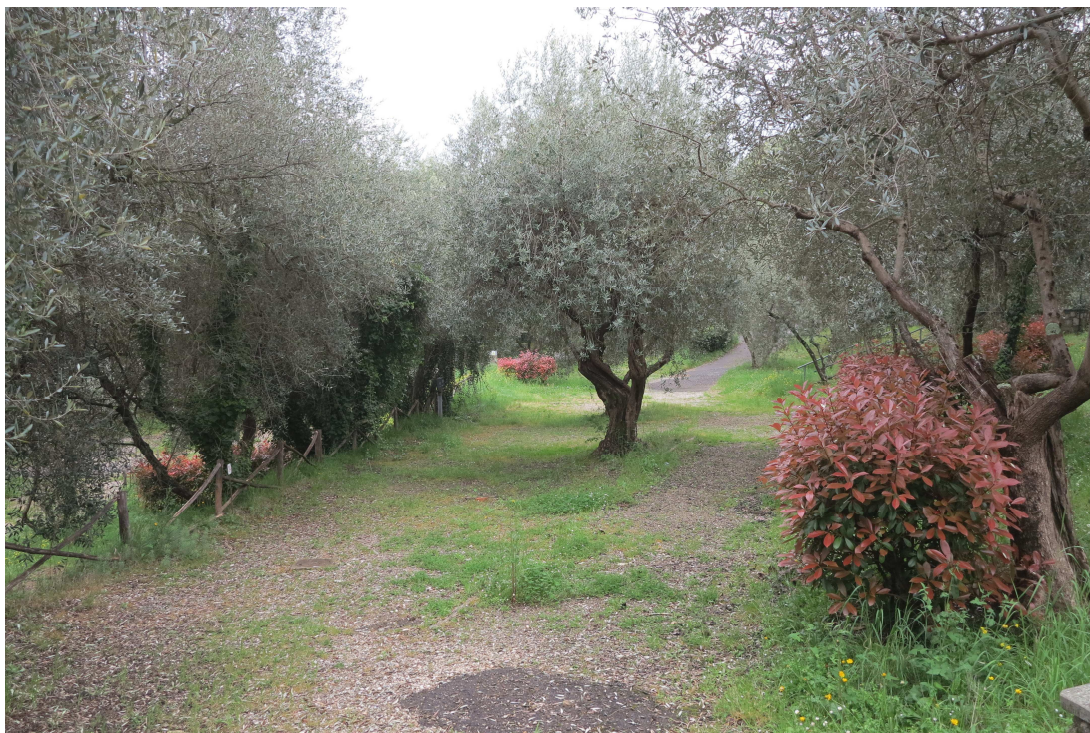
Veduta del piazzale alto dell'ex campeggio con palizzata deteriorata
