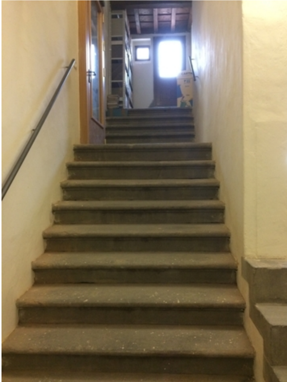
5. scala di accesso ai locali archivio del piano ammezzato passando dal piano terra
