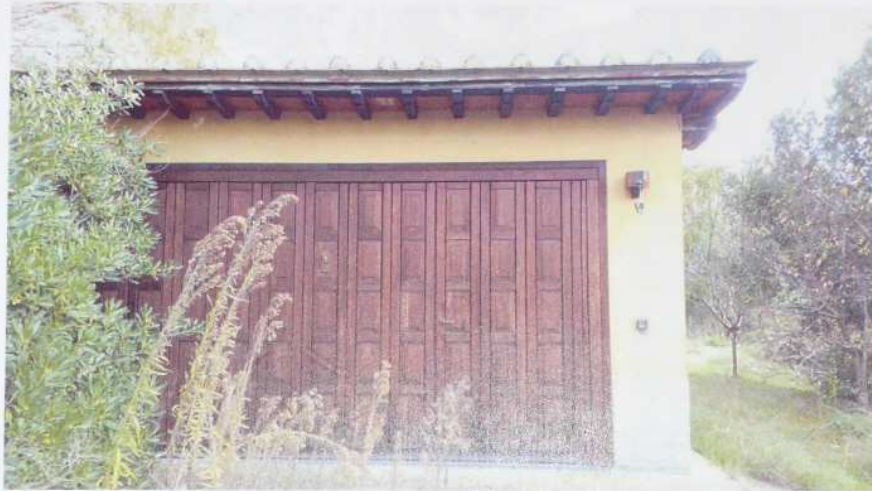
1 ingresso autorimessa lato ovest
