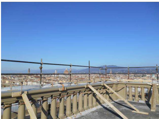
Foto 11 e 12 La balastra rimontata dopo l'intervento di restauro
