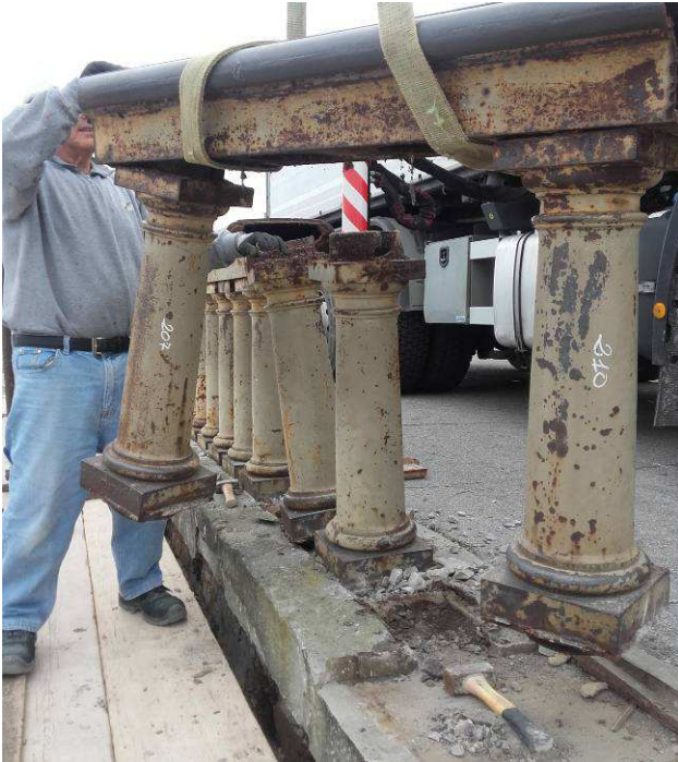
Foto_1 e 2 Lo smontaggio e numerazione della balaustre ed il degrado evidente dei colonnini alla base
