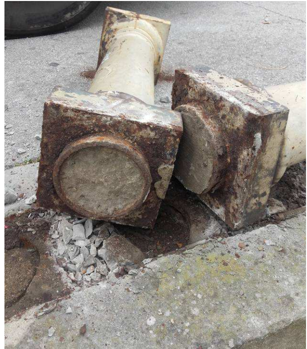
Foto_1 e 2 Lo smontaggio e numerazione della balaustre ed il degrado evidente dei colonnini alla base
