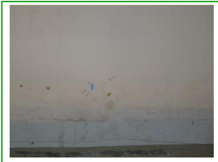
Foto n. 10: infiltrazioni d'acqua dalla copertura
