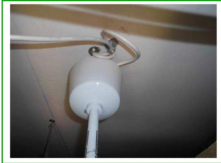
Foto n. 23: fissaggio ventilatore con filo elettrico
