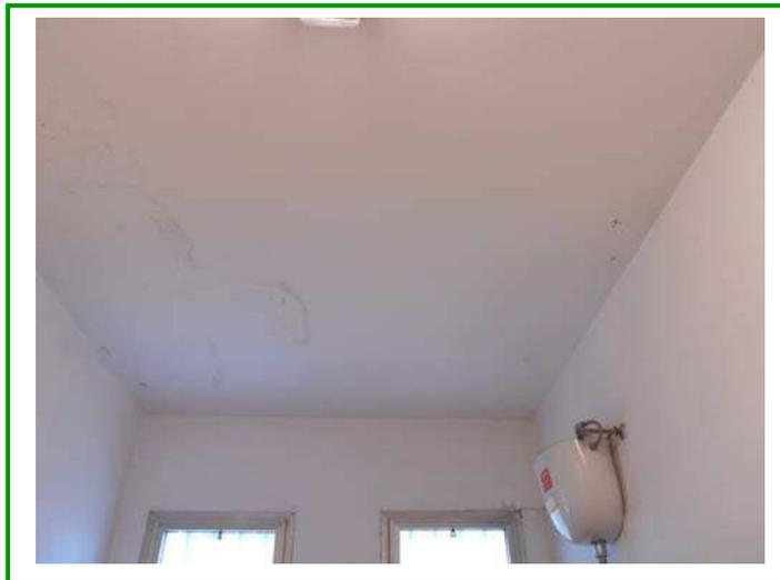
Foto n. 8: infiltrazioni a soffitto
