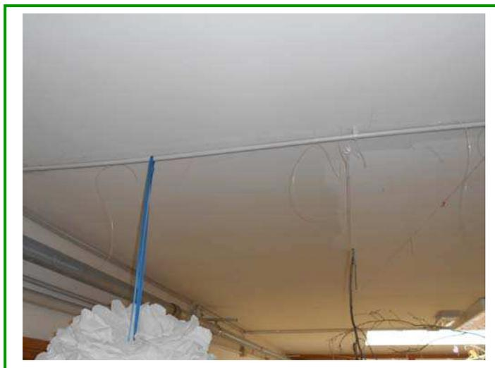
Foto n. 35: elementi appesi su tubo in plastica per elettricità
