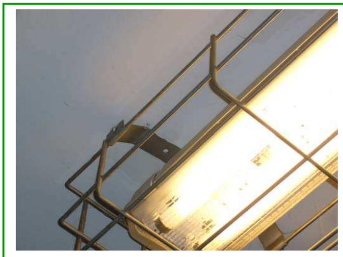
Foto n. 13: mancanza fissaggi protezione plafoniera (palestra)
