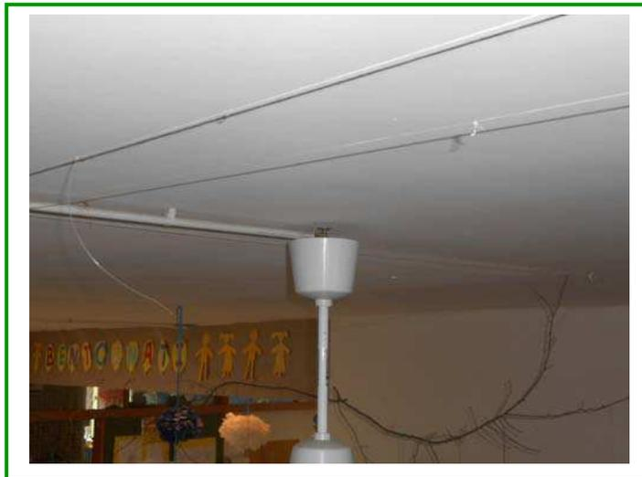
Foto n. 34: ventilatore senza fissaggio sicurezza
