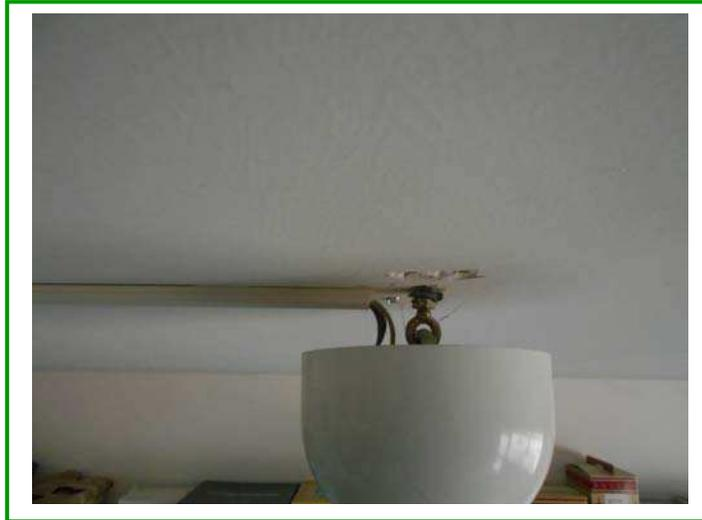
Foto n. 33: ventilatore senza fissaggio sicurezza
