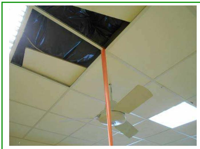
Foto n. 21: fissaggio alla struttura
