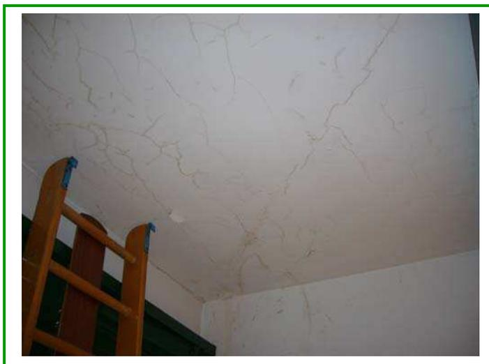
Foto n. 28: infiltrazioni e cavillature a soffitto
