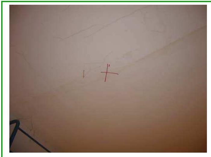
Foto n. 27: infiltrazioni a soffitto
