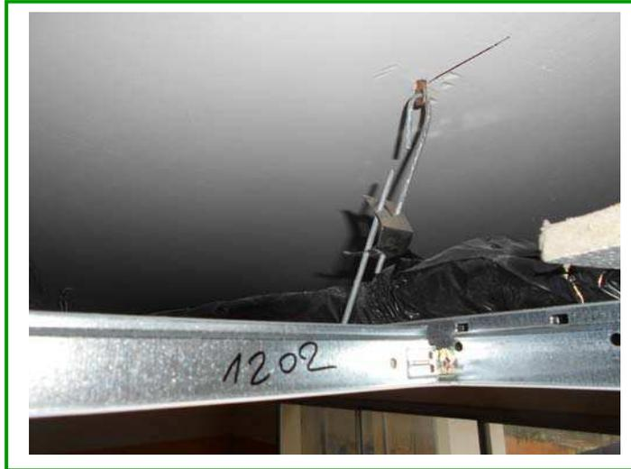
Foto n. 17: fissaggio a espansione e materassino
