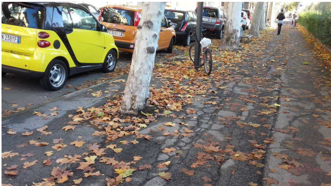
Figura 9: percorso ciclopedonale di via Venti Settembre (tra il ponte provvisorio e il ponte dei Bersaglieri)
