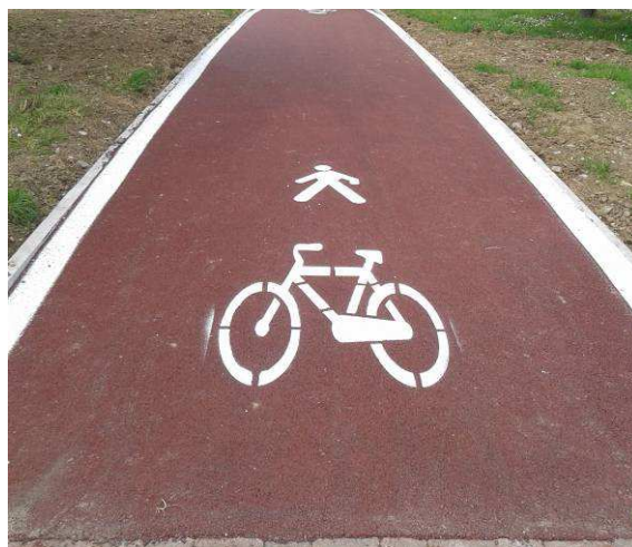
Figura 10: esempio di segnaletica orizzontale per percorso ciclopedonale
