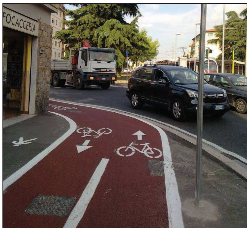
Fig. 3 – pista ciclabile separata da percorso pedonale mediante segnaletica orizzontale: esempio di segnaletica orizzontale con strisce di margine continue larghe 12 cm, striscia di mezzzeria tratteggiata larga 12 cm, simboli dei velocipedi con freccia di direzione e del pedone.
