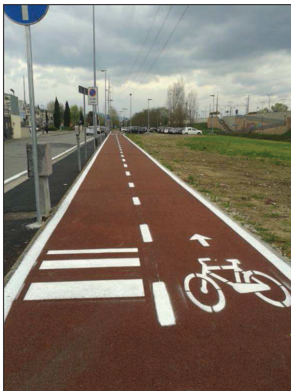
Fig. 1 - esempio di pavimentazione in conglomerato rosso colorato in pasta
