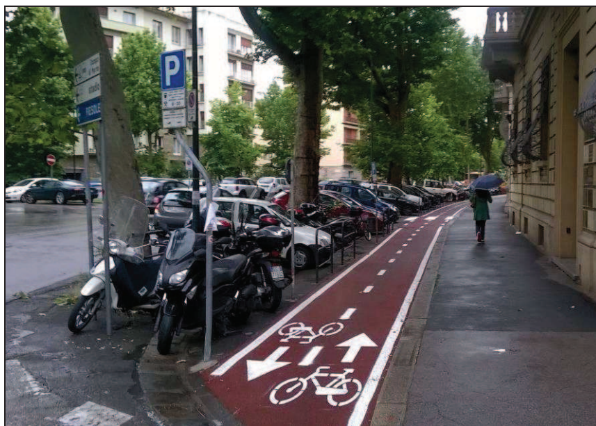
Fig. 2 - pista ciclabile in sede propria: esempio di segnaletica orizzontale con strisce di margine continue larghe 12 cm, striscia di mezzzeria tratteggiata larga 12 cm e simboli dei velocipedi con frecce indicanti il senso di marcia delle corsie.
