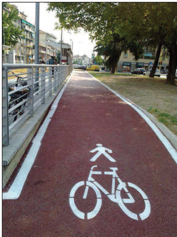
Fig. 4 – percorso ciclabile in promiscuo con i pedoni: esempio di segnaletica orizzontale con strisce di margine continue larghe 12 cm e simboli del velocipede e del pedone.
