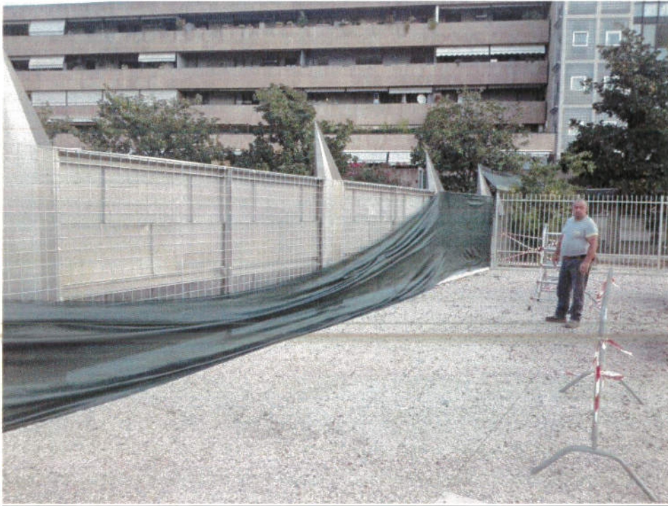
Completamento recinzione lato Via Santelli
