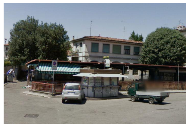
Ex Acquadotto – foto esterno
