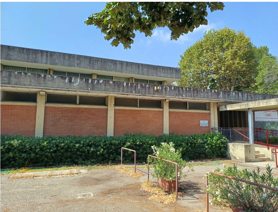
Piazzale esterno lato ingresso pedonale
