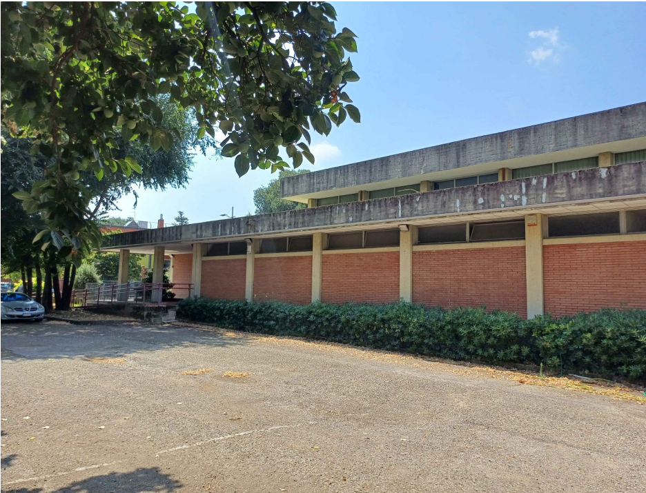
Piazzale esterno lato ingresso carrabile
