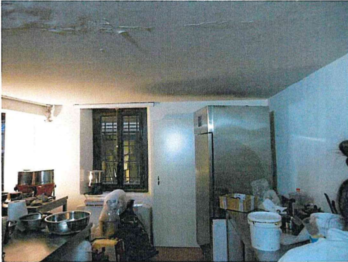
Porzione "A"- Veduta interna del locale
