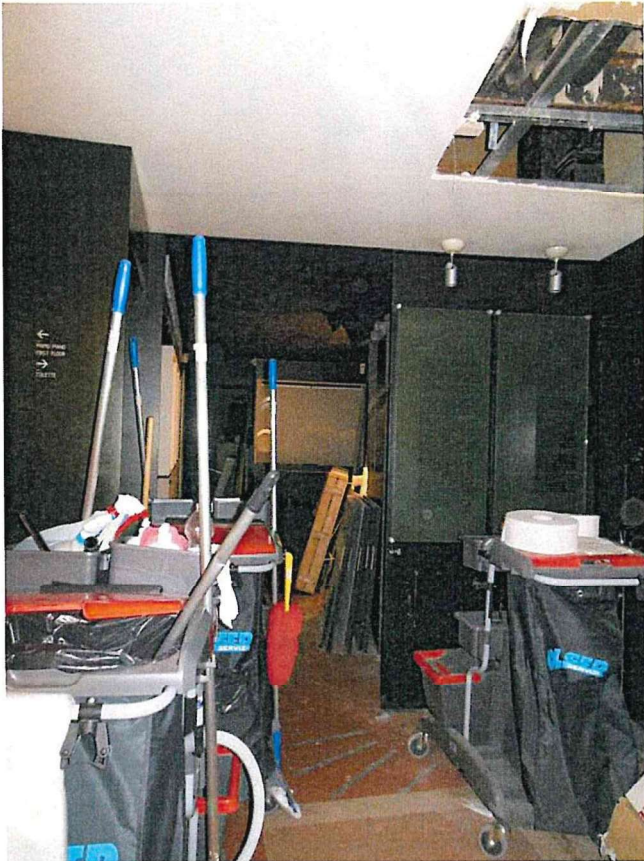
Porzione "B" Vista interna del locale
