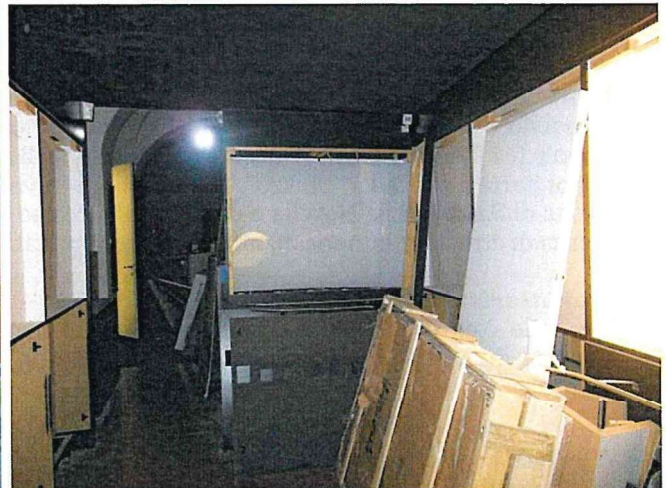
Porzione "B" Vista interna del locale
