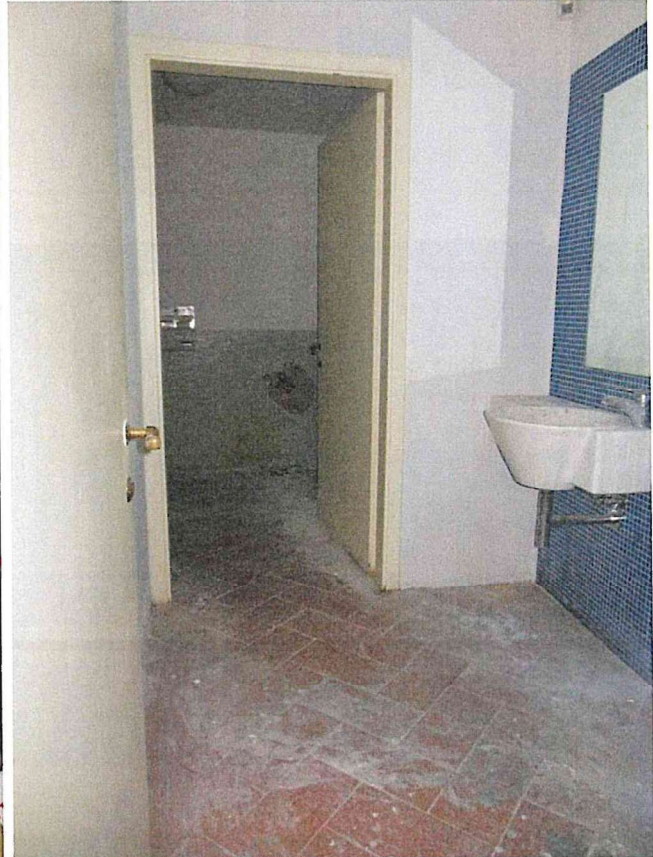
Porzione "B" Vista interna zona servizio igienico
