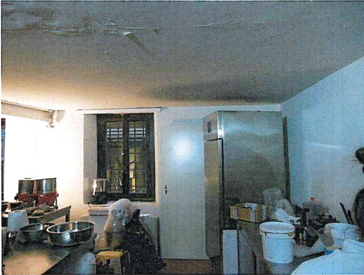
Porzione "A"- Veduta interna del locale
