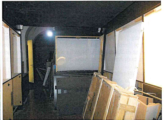
Porzione "B" Vista interna del locale
