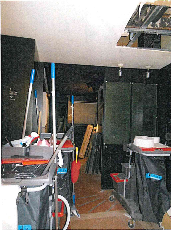
Porzione "B" Vista interna del locale
