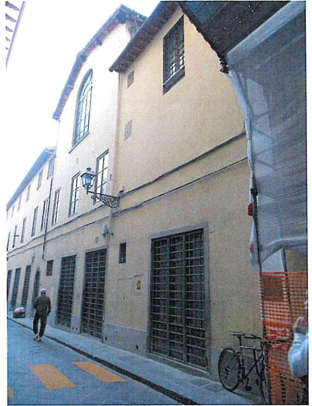
Porzione "B" Vista esterna da Via Palazzuolo – accesso dal n.c. 12r
