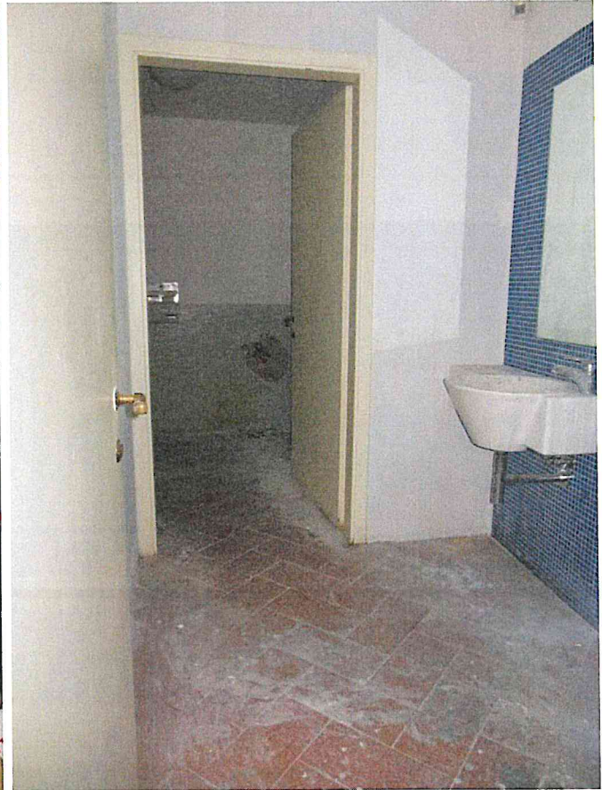
Porzione "B" Vista interna zona servizio igienico
