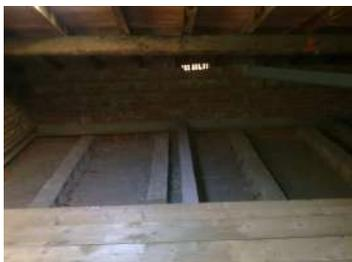
**Scuola Elementare Locchi: Inserimento rete antisfondellamento sopra il controsoffitto del piano primo e revisione impianti illuminazione**
