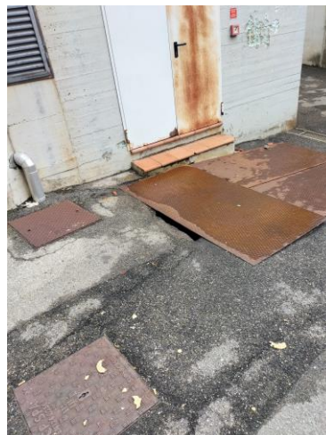
Porta esterna da installare barriere anti-topo e pozzetto esterno da far chiudere correttamente
