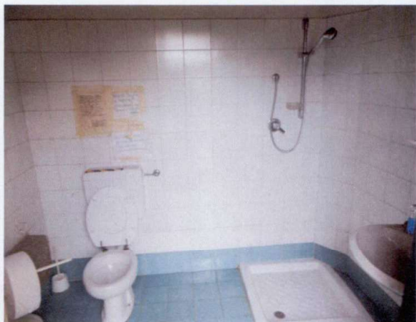
foto 9 – un servizio igienico del fabbricato secondario
