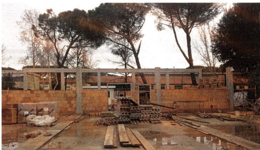
I lavori della palestra in corso d'opera
